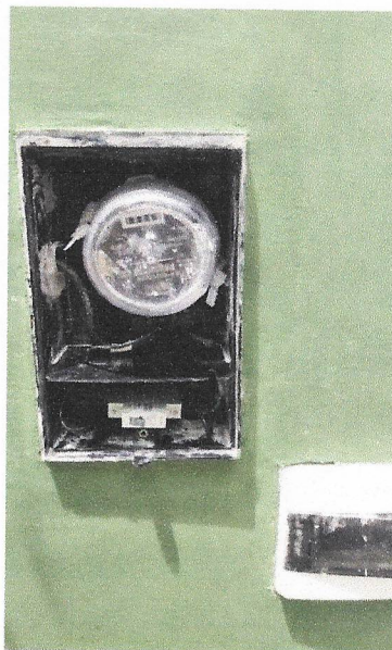
Foto 02 – Execução do padrão.
