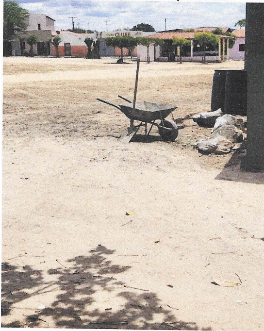
Foto 19- Execução da Limpeza Final.
