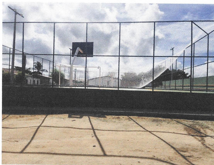
Foto 18- Execução da tela de Nylon.
