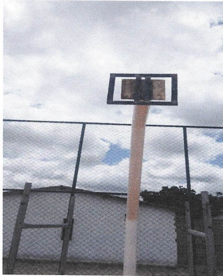
Foto 09- Execução do fundo para colocar a tabela.
