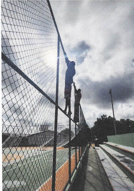
Foto 16- Execução da Tela de Nylon.
