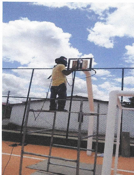
Foto 09- Execução do fundo para colocar a tabela.
