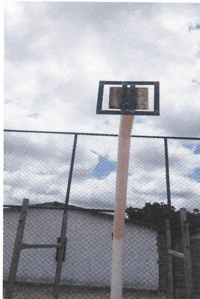
Foto 09- Execução do fundo para colocar a tabela.
