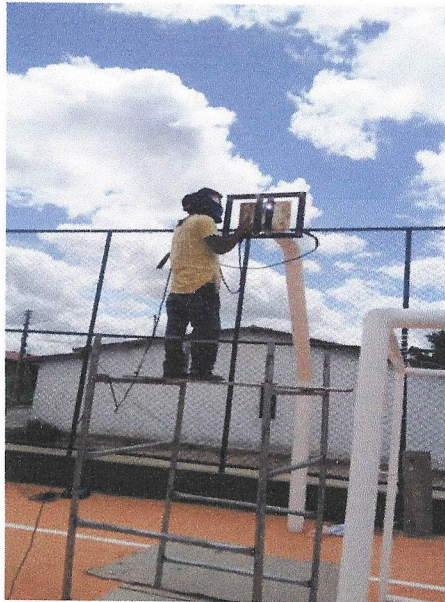
Foto 09- Execução do fundo para colocar a tabela.
