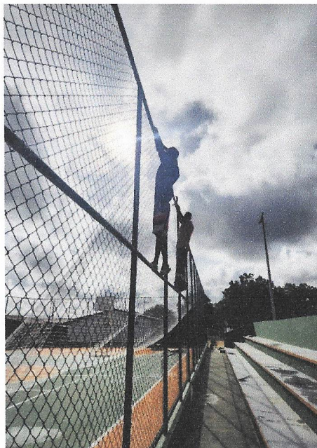
Foto 16- Execução da Tela de Nylon.
