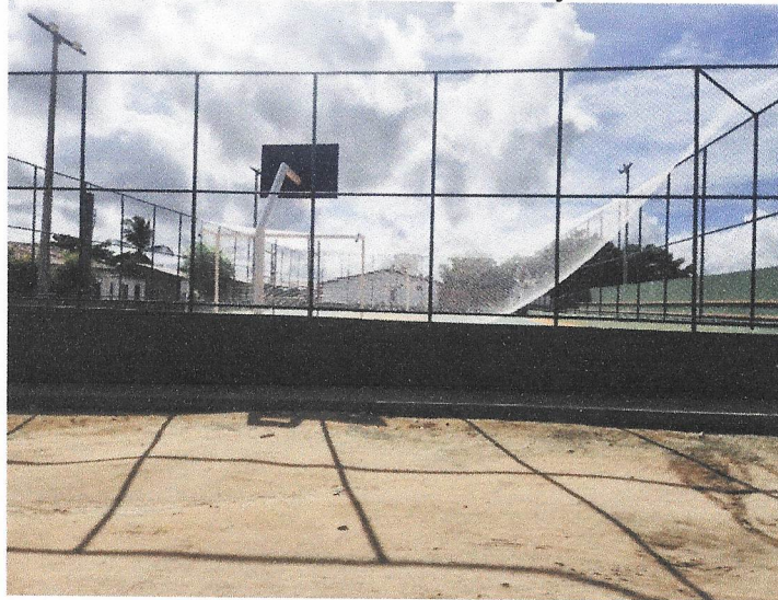
Foto 18- Execução da tela de Nylon.
