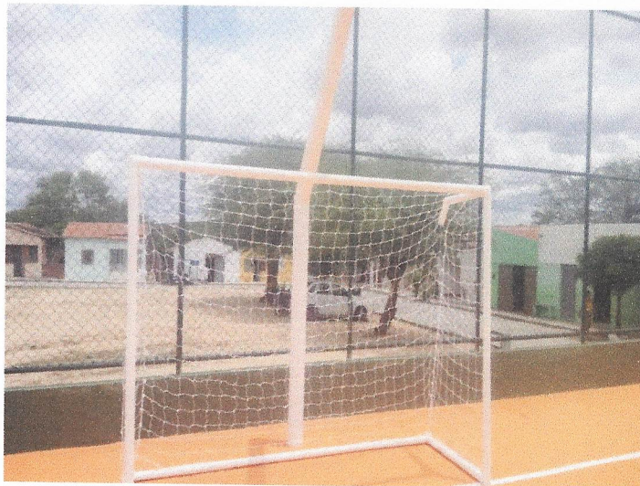
Foto 23– Execução da Rede da trave.
