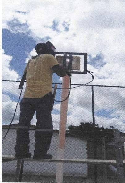
Foto 09- Execução do fundo para colocar a tabela.
